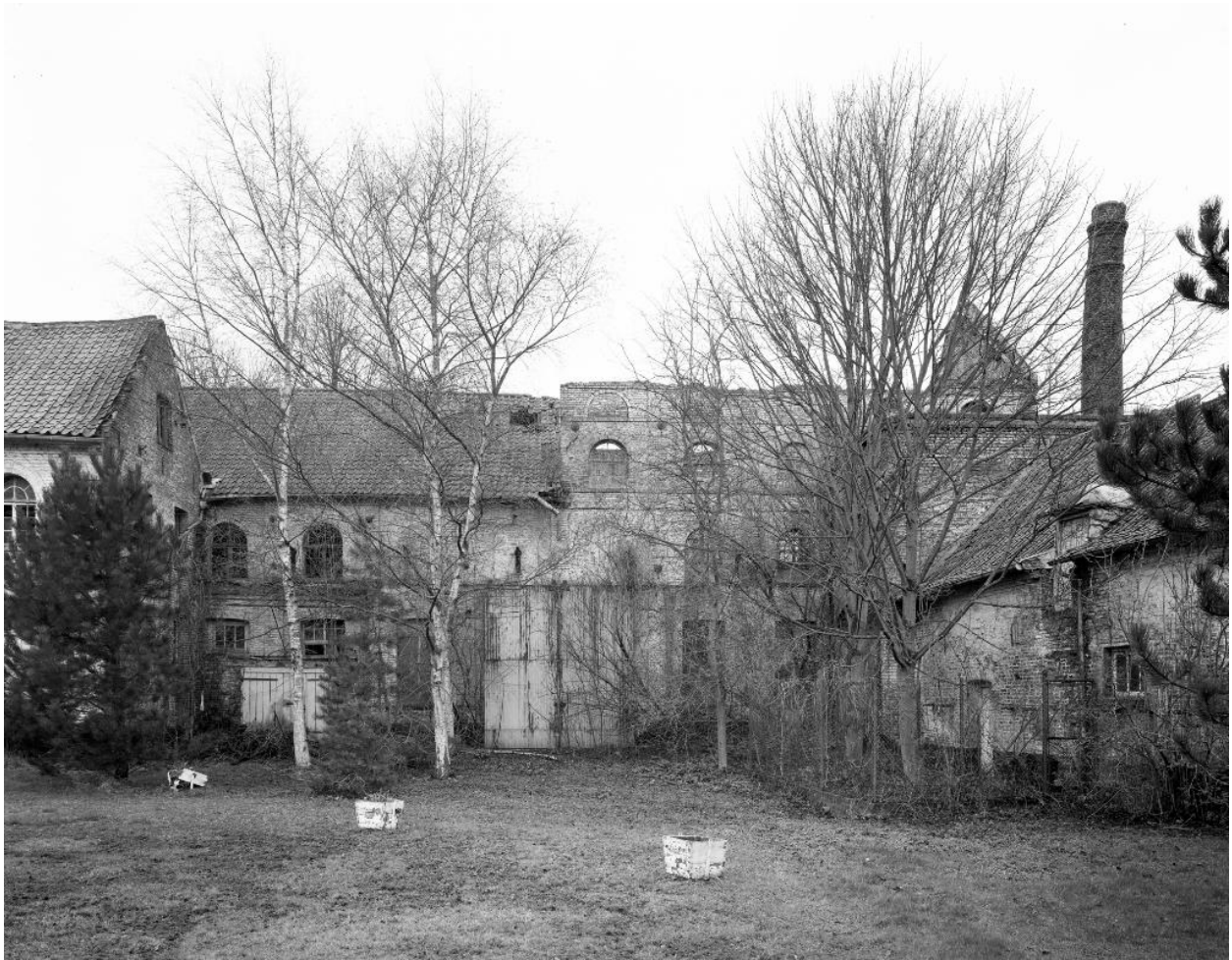
Ferme des Berceaux en 1999 : angle nord-est de la cour : extrémité de l'écurie et de l'atelier de fabrication de noir animal, cheminée de la râperie et écurie-porcherie.
