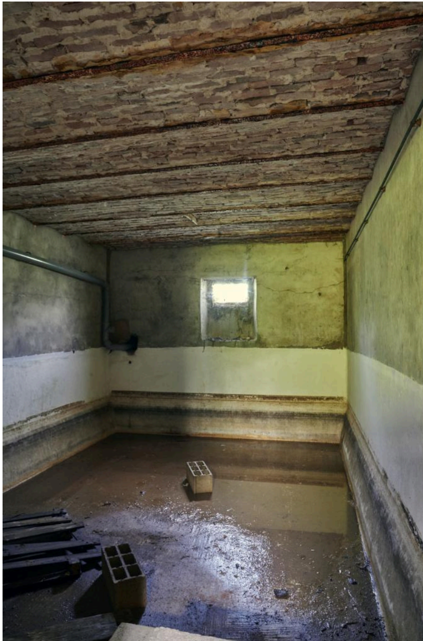
Sous-sol du logement du chef d'élevage.
