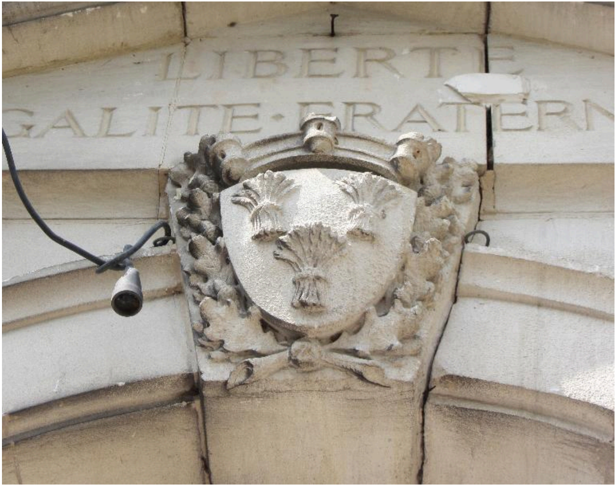
Détail des armoiries de la ville figurées en agrafe de l'entrée de la façade sur rue.
