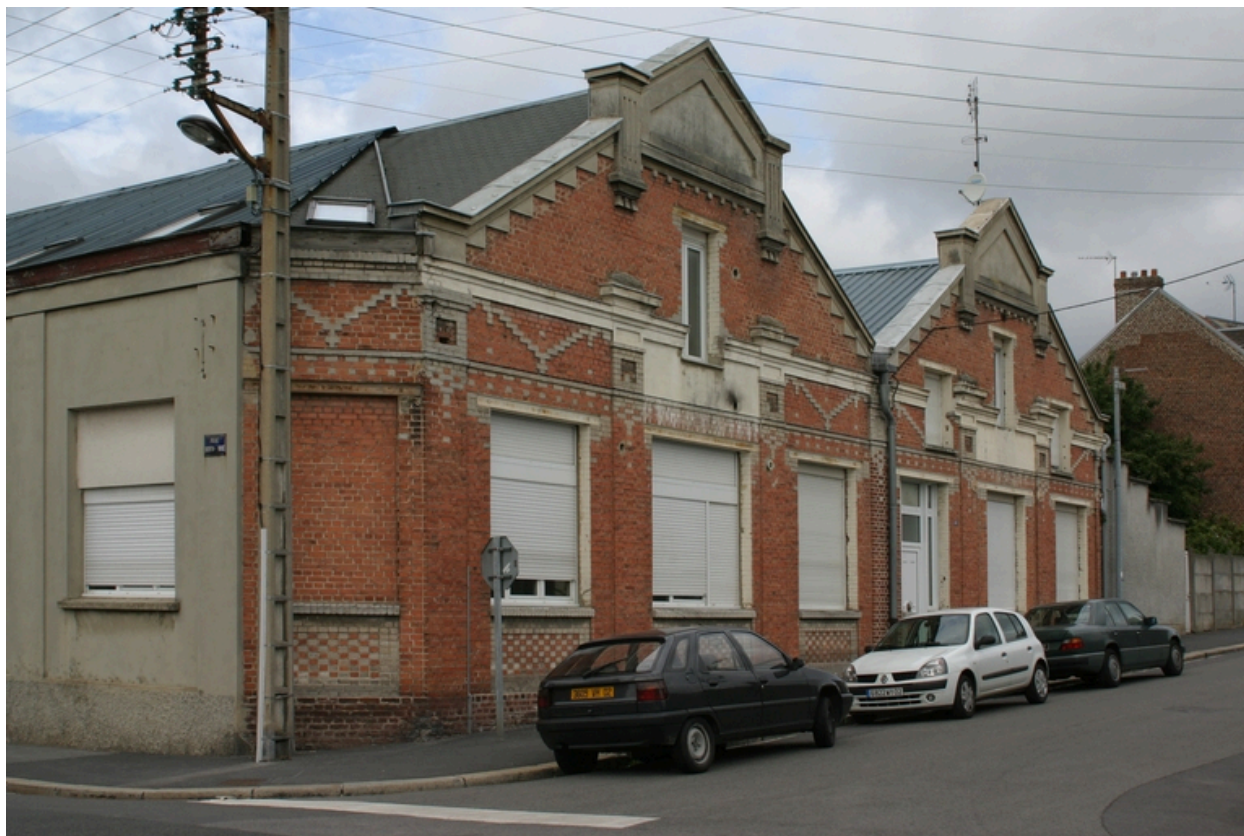
Façade antérieure des ateliers (pignons nord-est).
