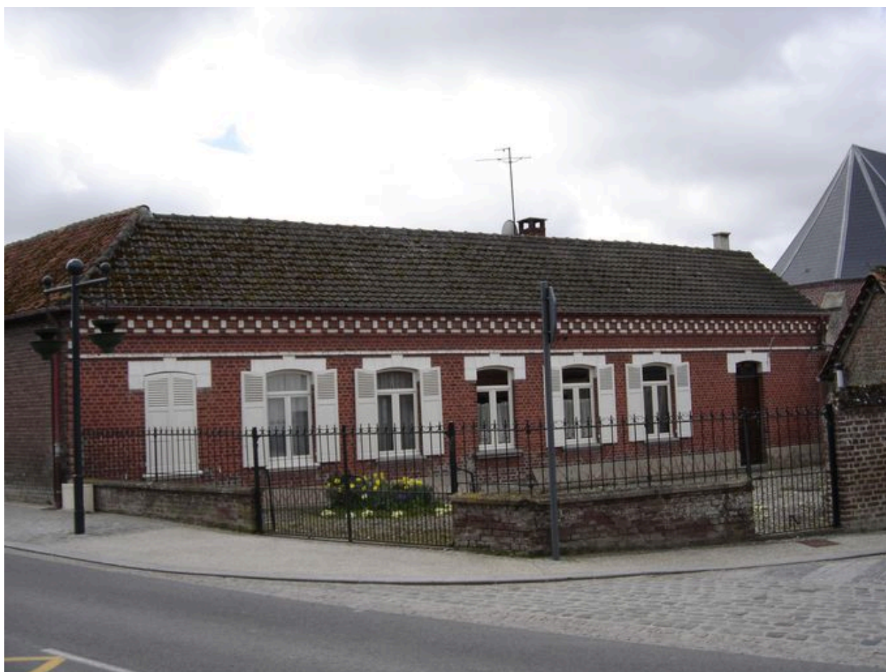
Vue générale du logis depuis la rue.
