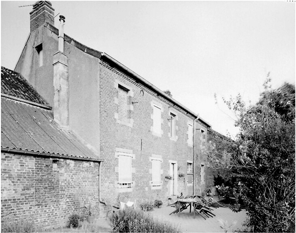
Vue de l'élévation postérieure du logis.
