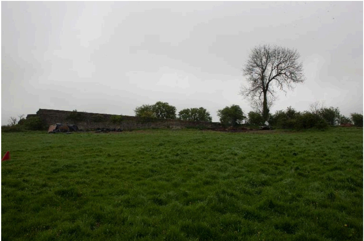
Murs de protection de la rampe de lancement : vue générale.
