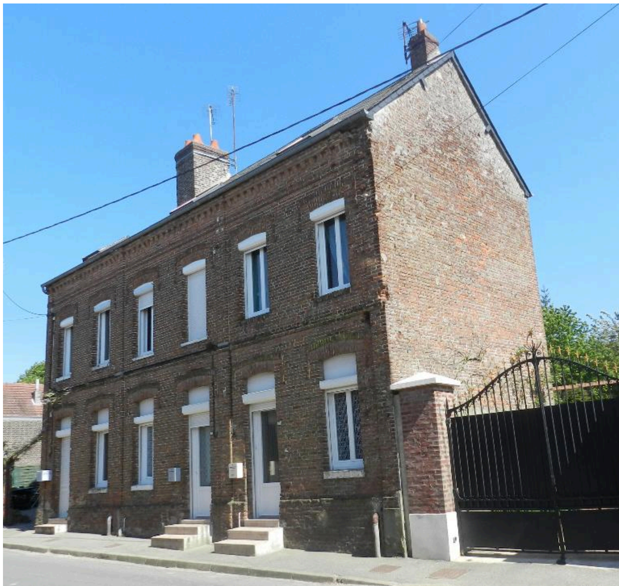
Ensemble de trois logements de contremaître, 13 à 17 rue Joliot-Curie, construits pour Frenkl, en 1872.
