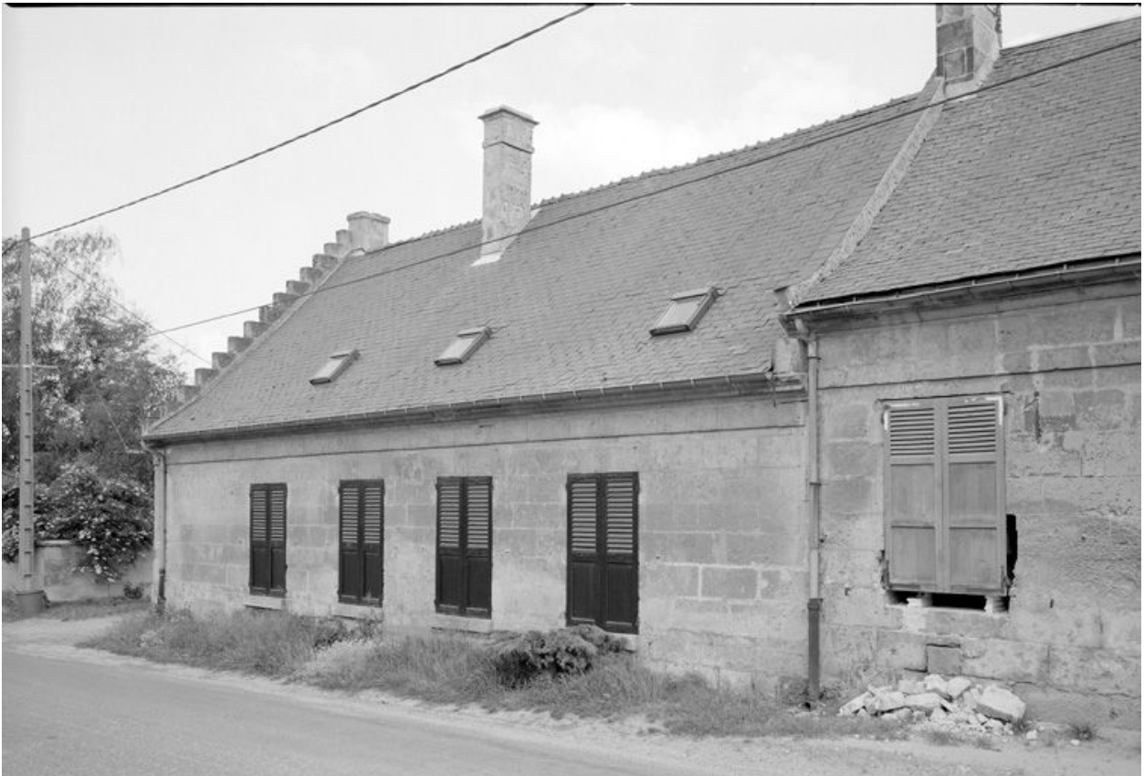
Logis. Élévation sur rue.
