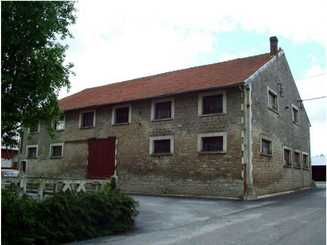
Vue d'un bâtiment agricole.
