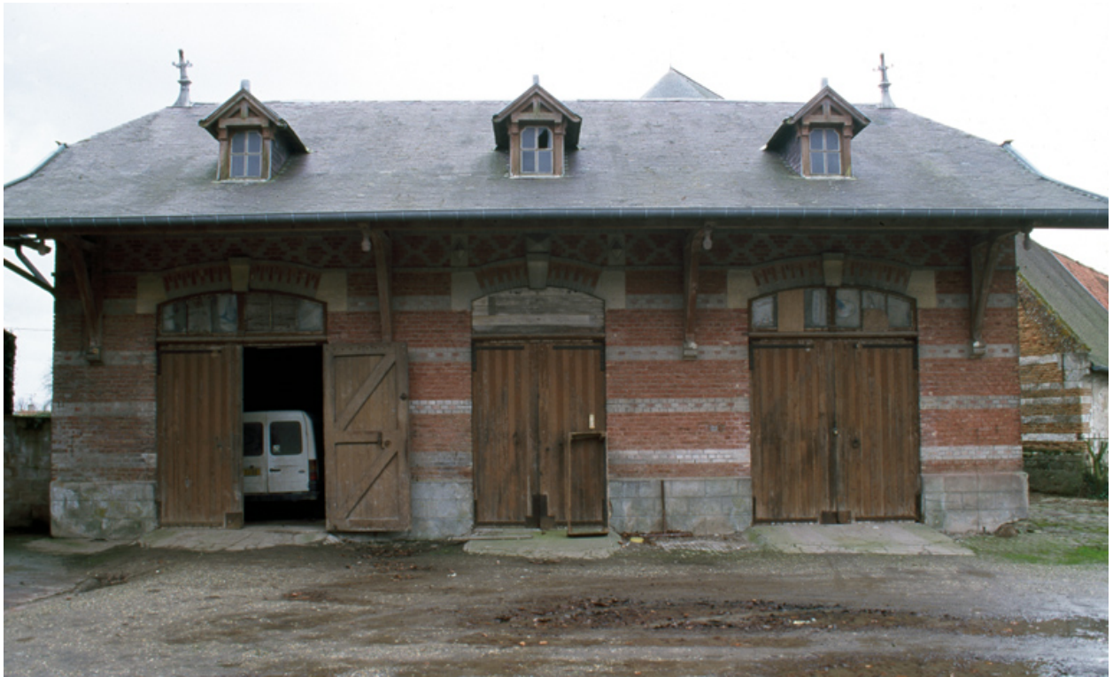
Remises et écuries.
