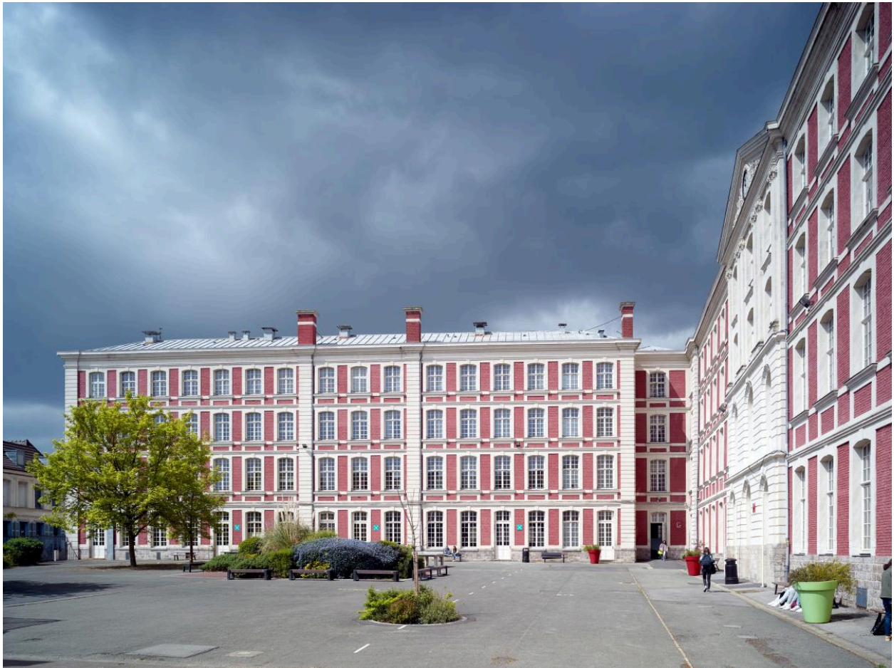
Vue de la façade sur la cour des élèves de la partie de l'aile bordant la rue Saint-Albin.
