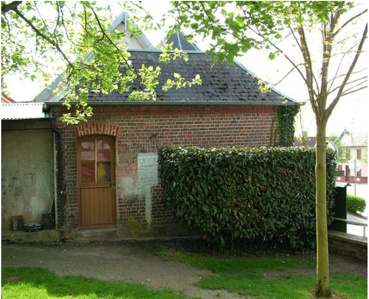
Ancienne remise de matériel d'incendie.
