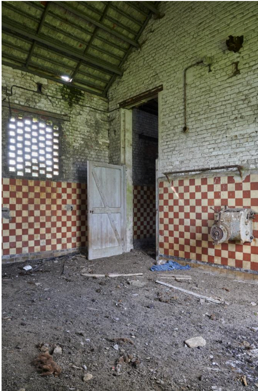
Porte d'entrée de la salle d'abattage.
