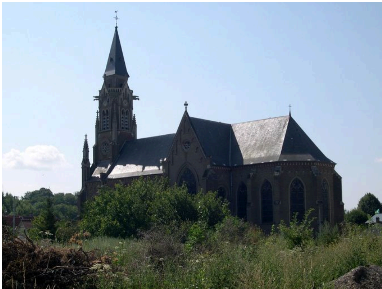
Vue de situation depuis le nord-ouest.
