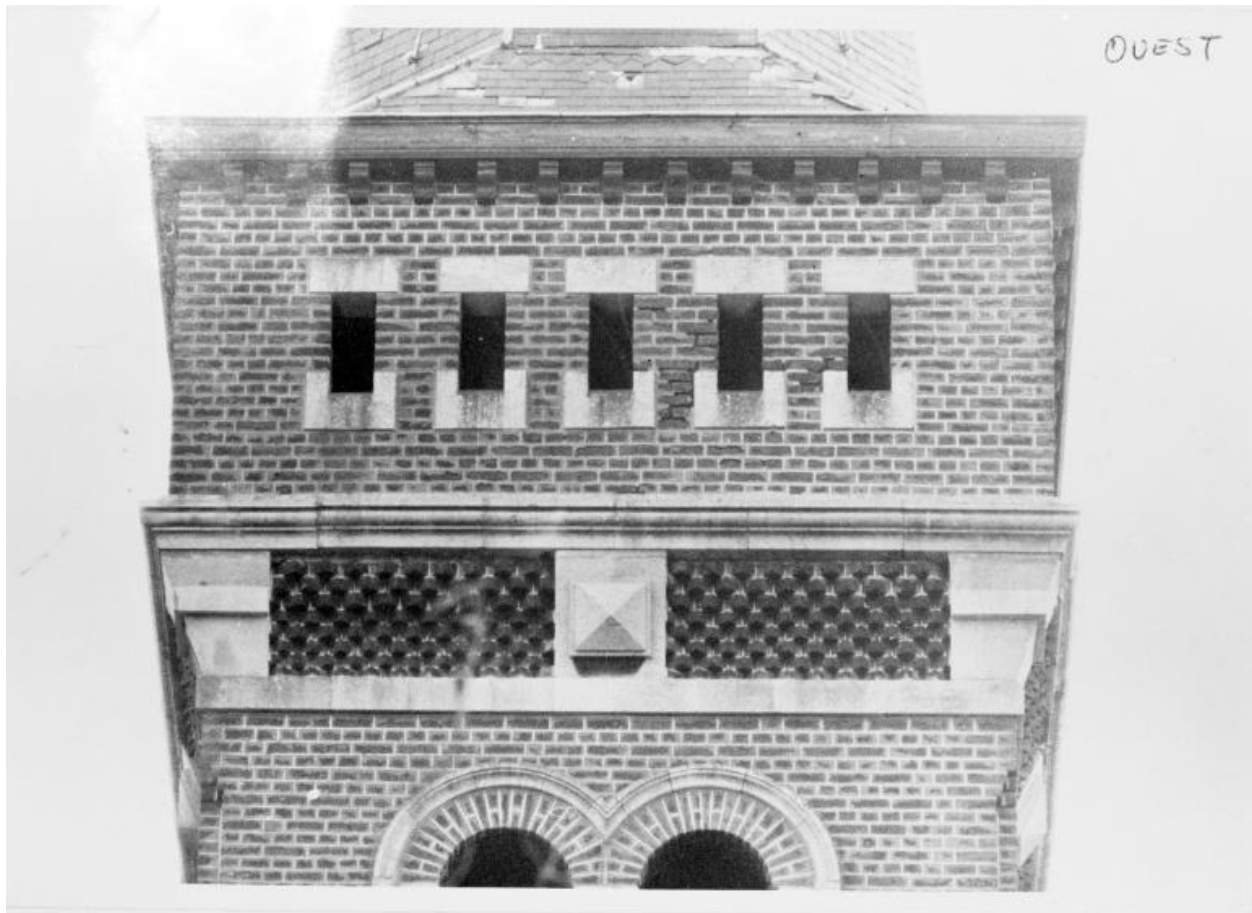
Détail de la face ouest du clocher. (Archives des Houillères).
