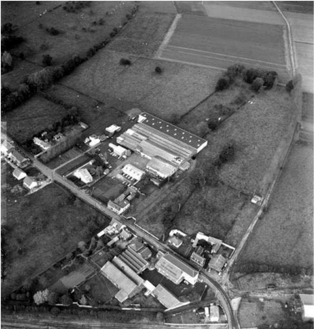
Vue aérienne de l'usine, flanc sud-est, en 1998.
