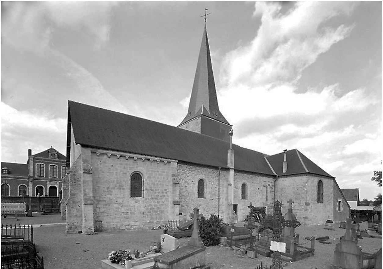
Vue générale de l'élévation sud.
