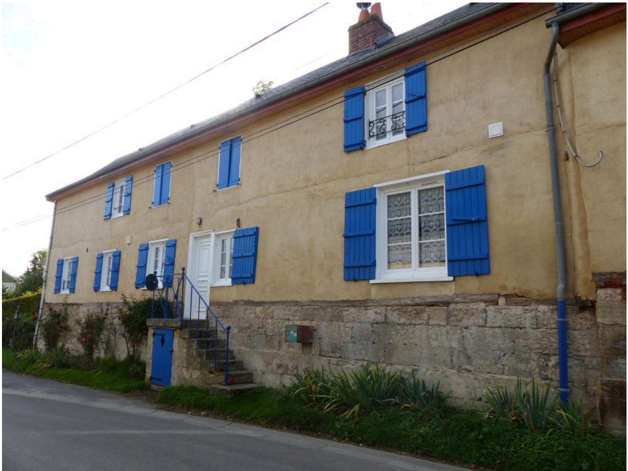
Logis datant pour partie de 1792, n°3 rue du Chauffour, vue depuis le nord-est.
