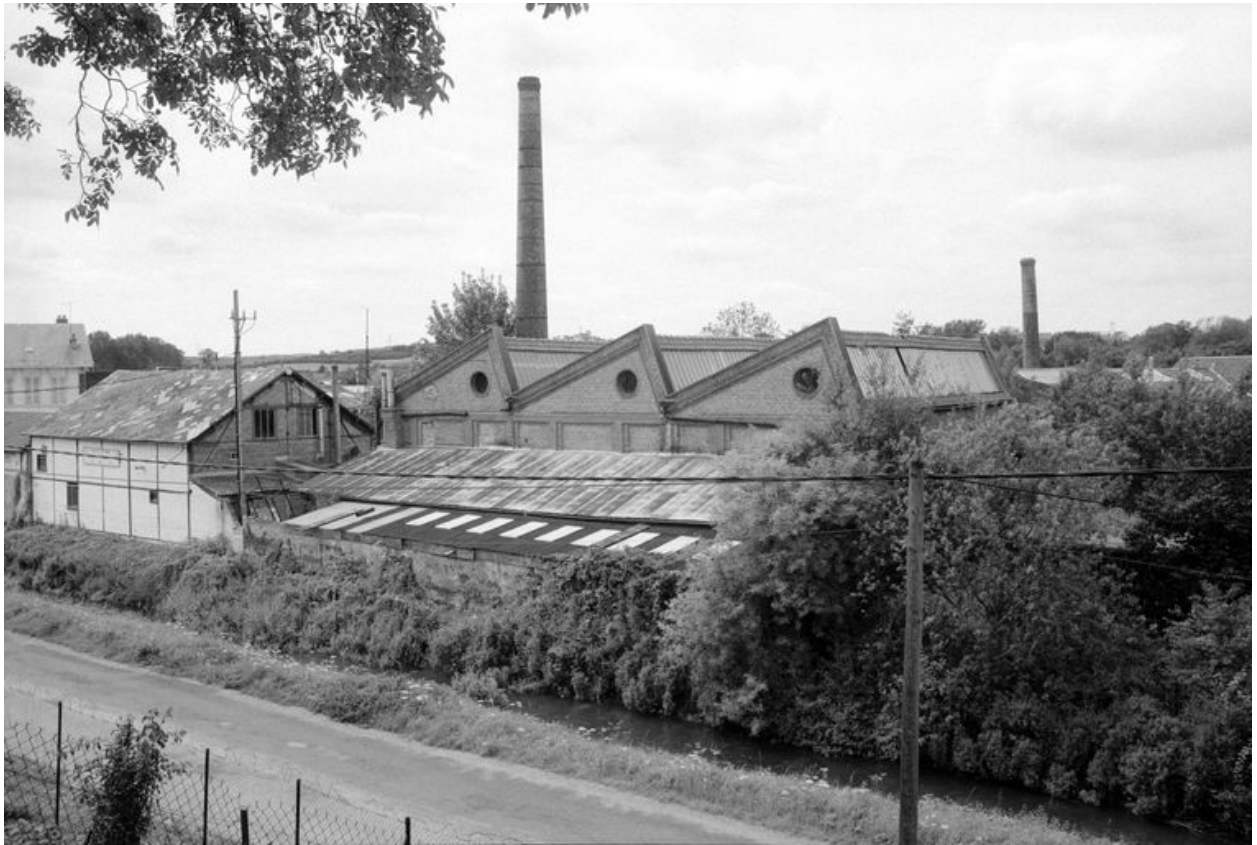
Vue partielle, flanc sud-est.
