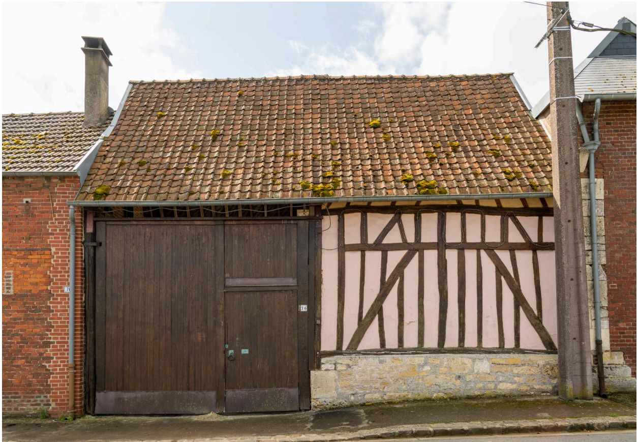
Grange sur rue, n°76 de la Grande Rue, vue prise depuis le nord.
