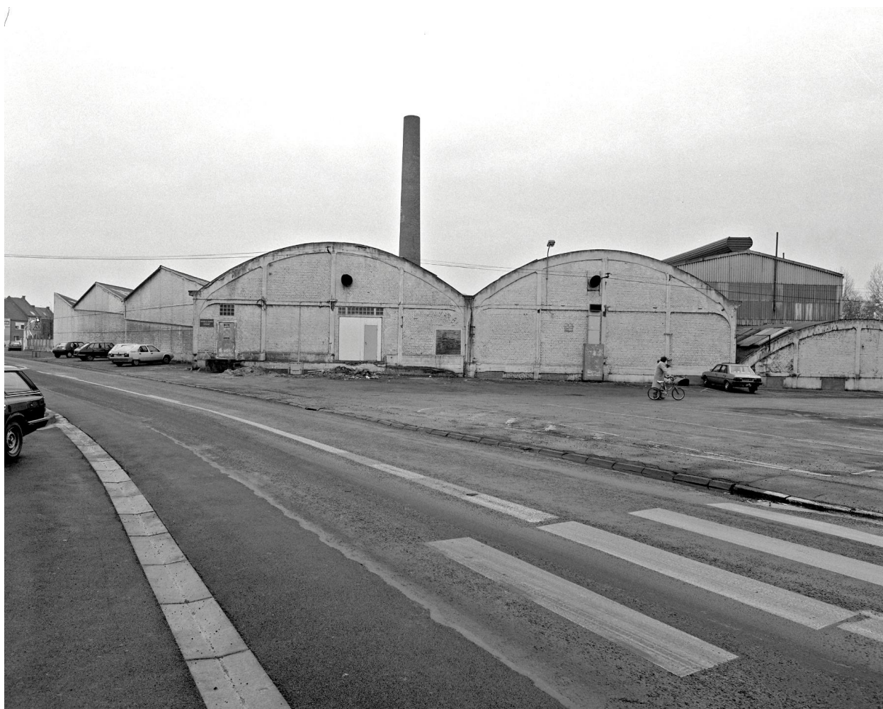
Vue générale prise vers le sud.
