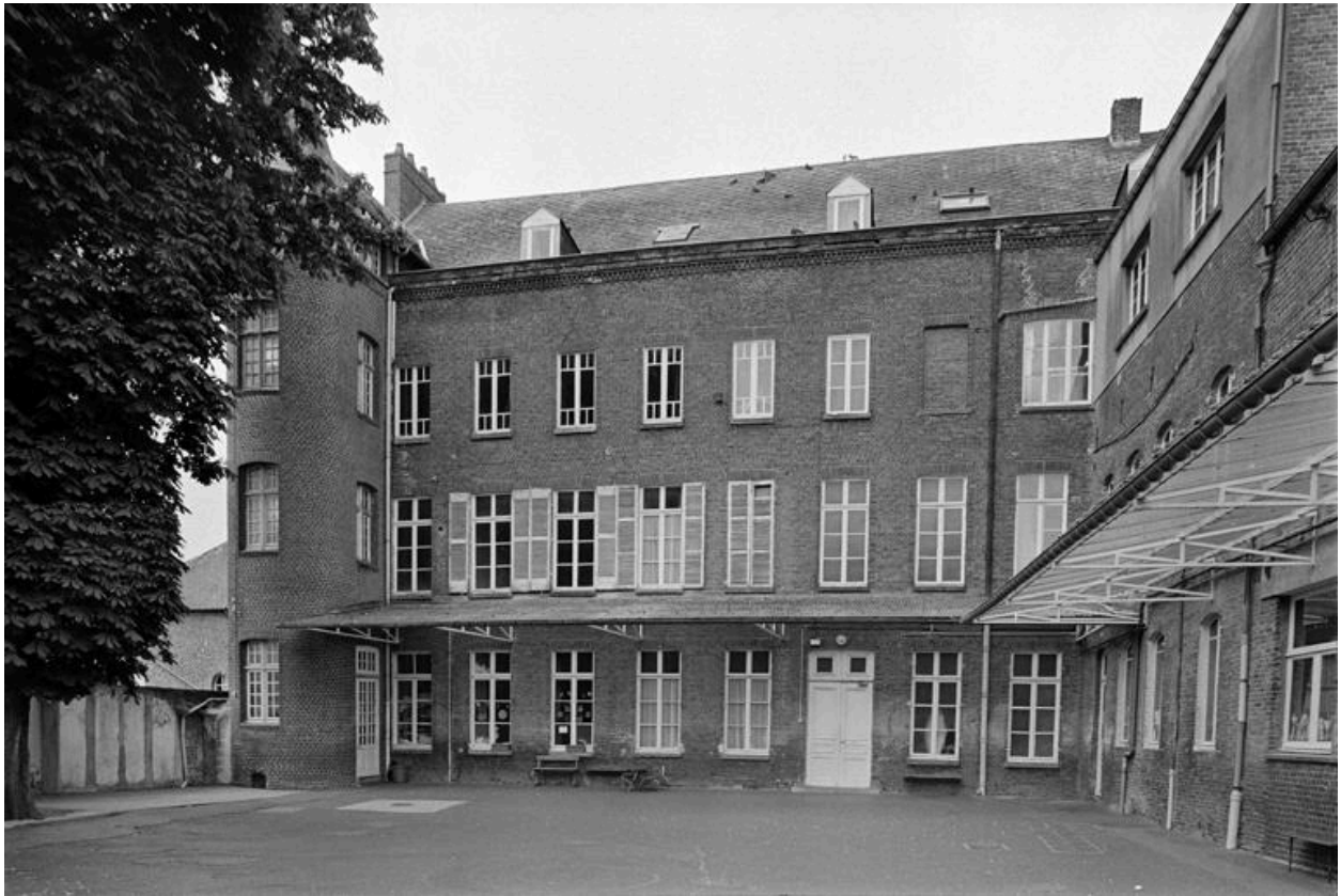
Vue de la façade sur cour.
