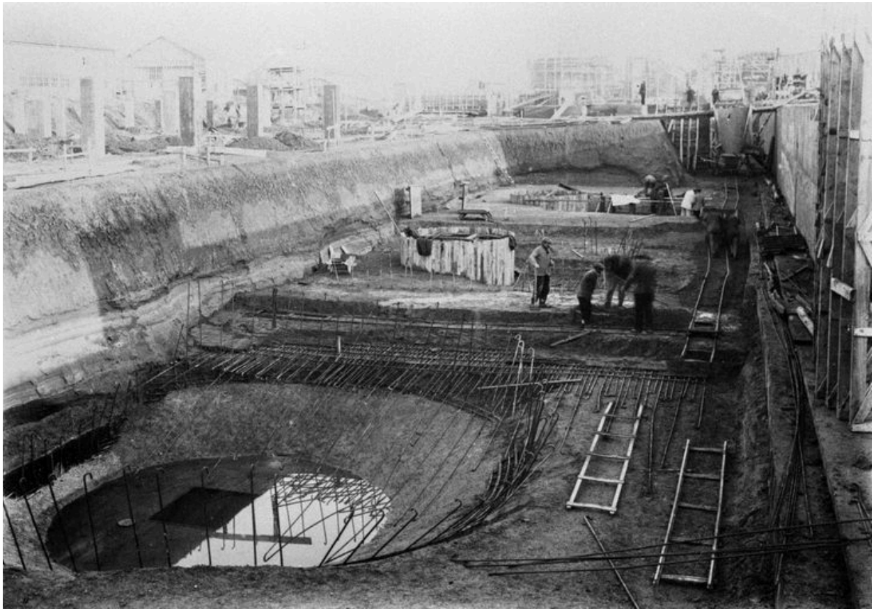
Fondation des cheminées de l'usine, 1921 (AC Thourotte).
