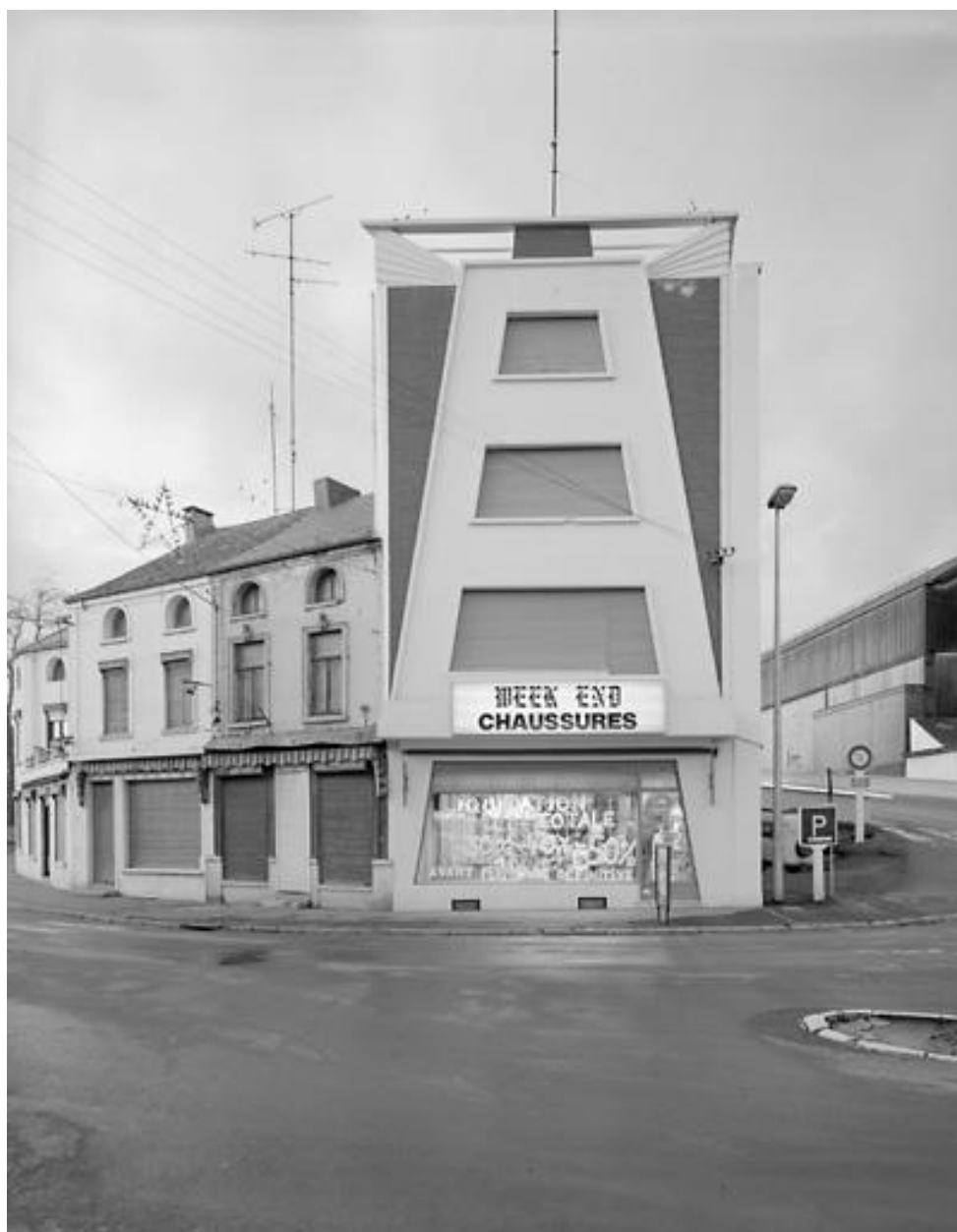
Vue générale de l'élévation antérieure.
