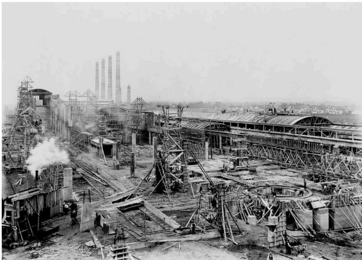
Construction des ateliers, vers 1925 (AP).
