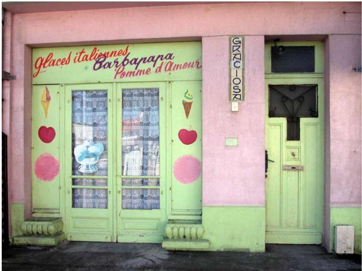
Détail de l'élévation du rez-de-chaussée.
