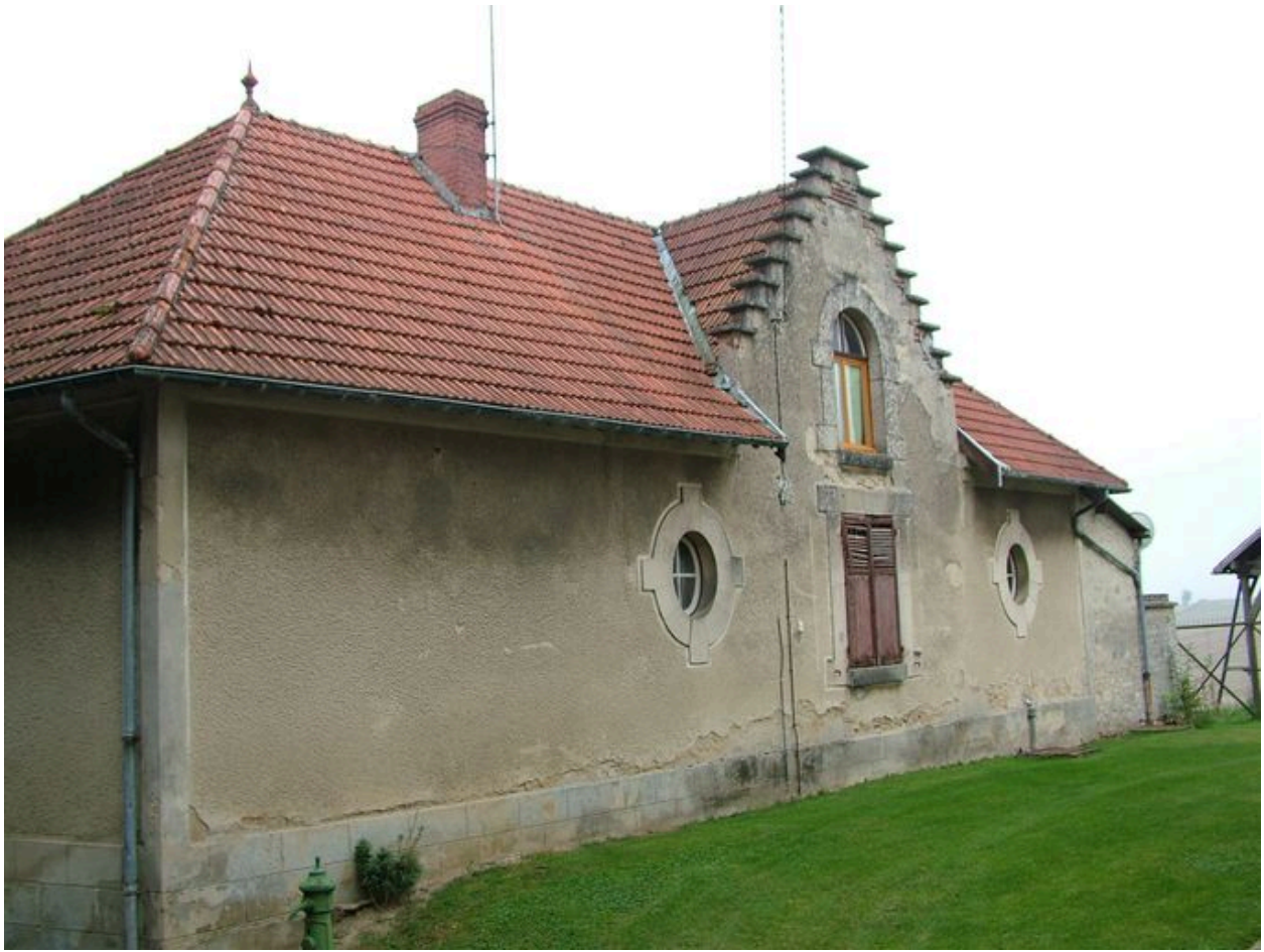
Vue postérieure du logis.
