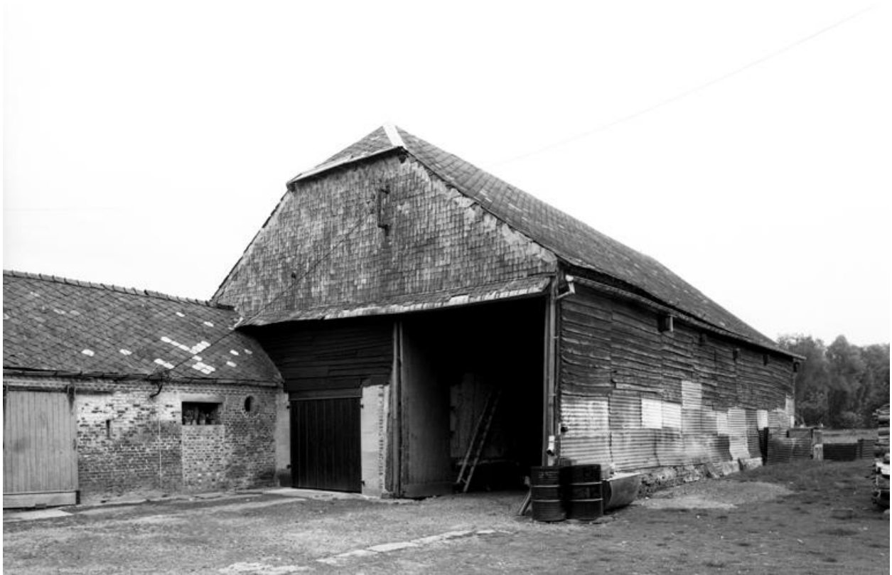
Vue d'ensemble de la grange, depuis le sud-est.
