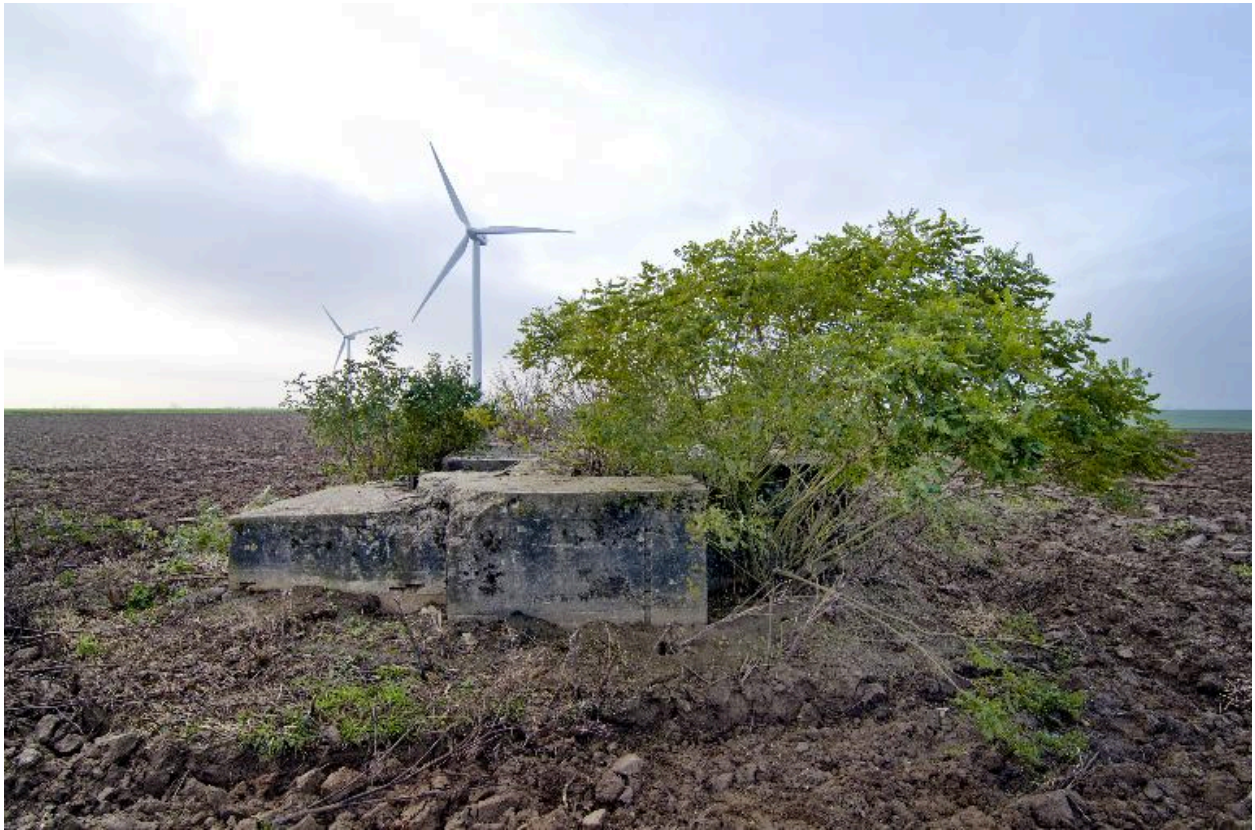
Vue latérale, vers le nord-ouest
