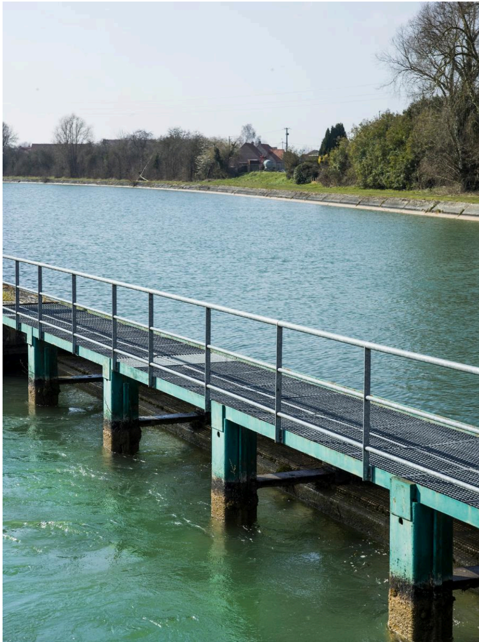
Estacade de guidage, passerelle métallique du bassin de tranquillisation à l'aval de l'écluse.
