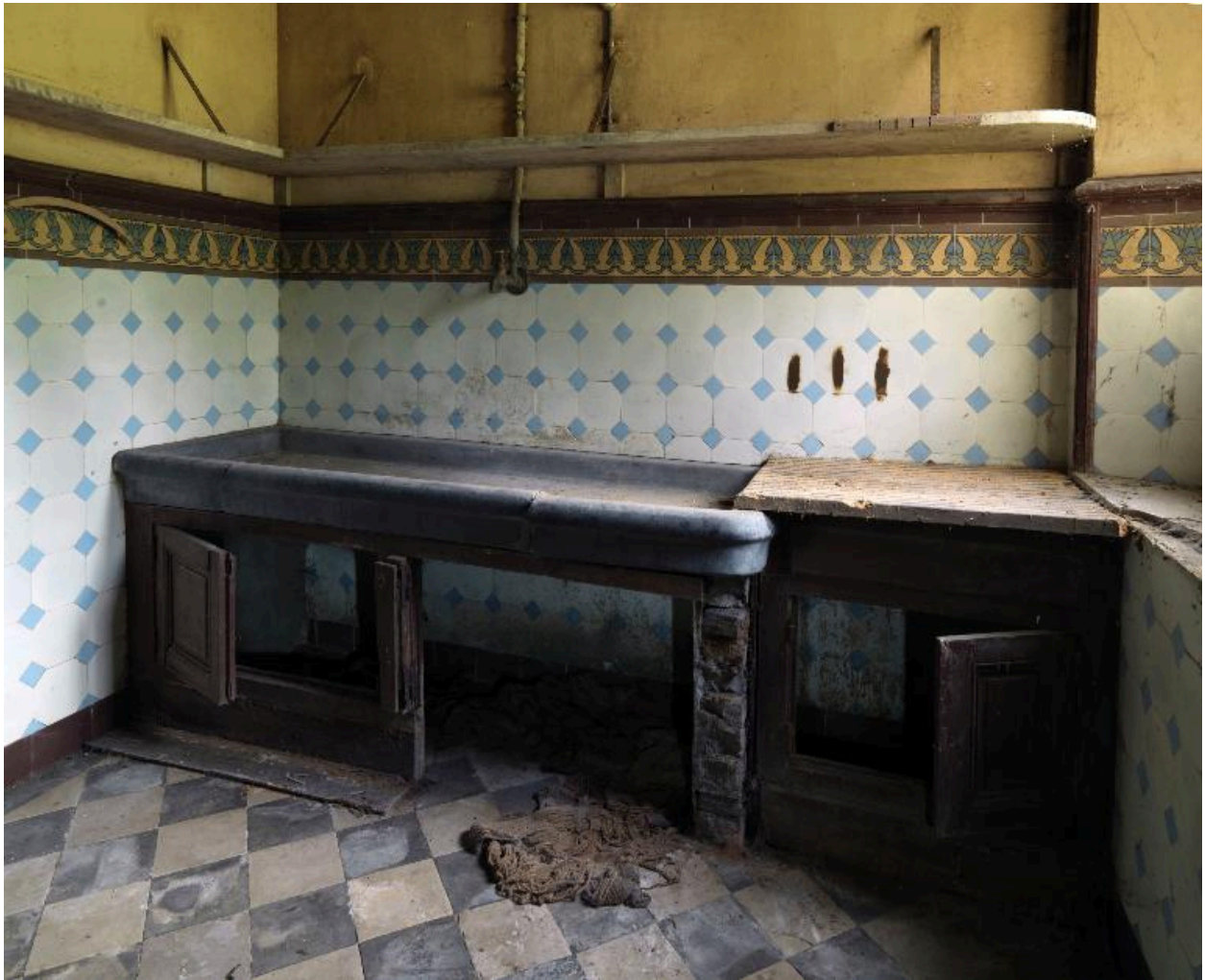
Souillarde attenante à la cuisine secondaire du sous-sol.
