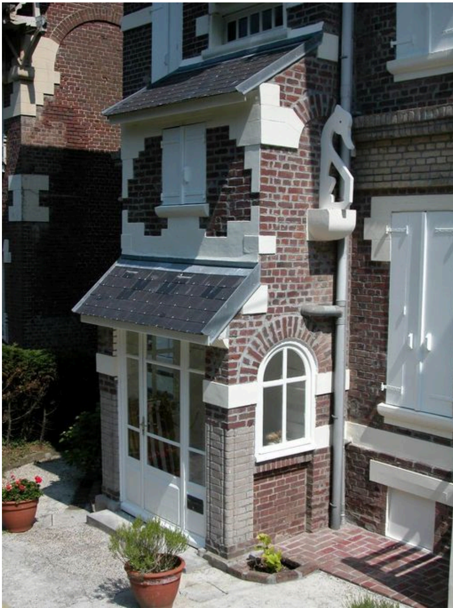
Détail du porche d'entrée.
