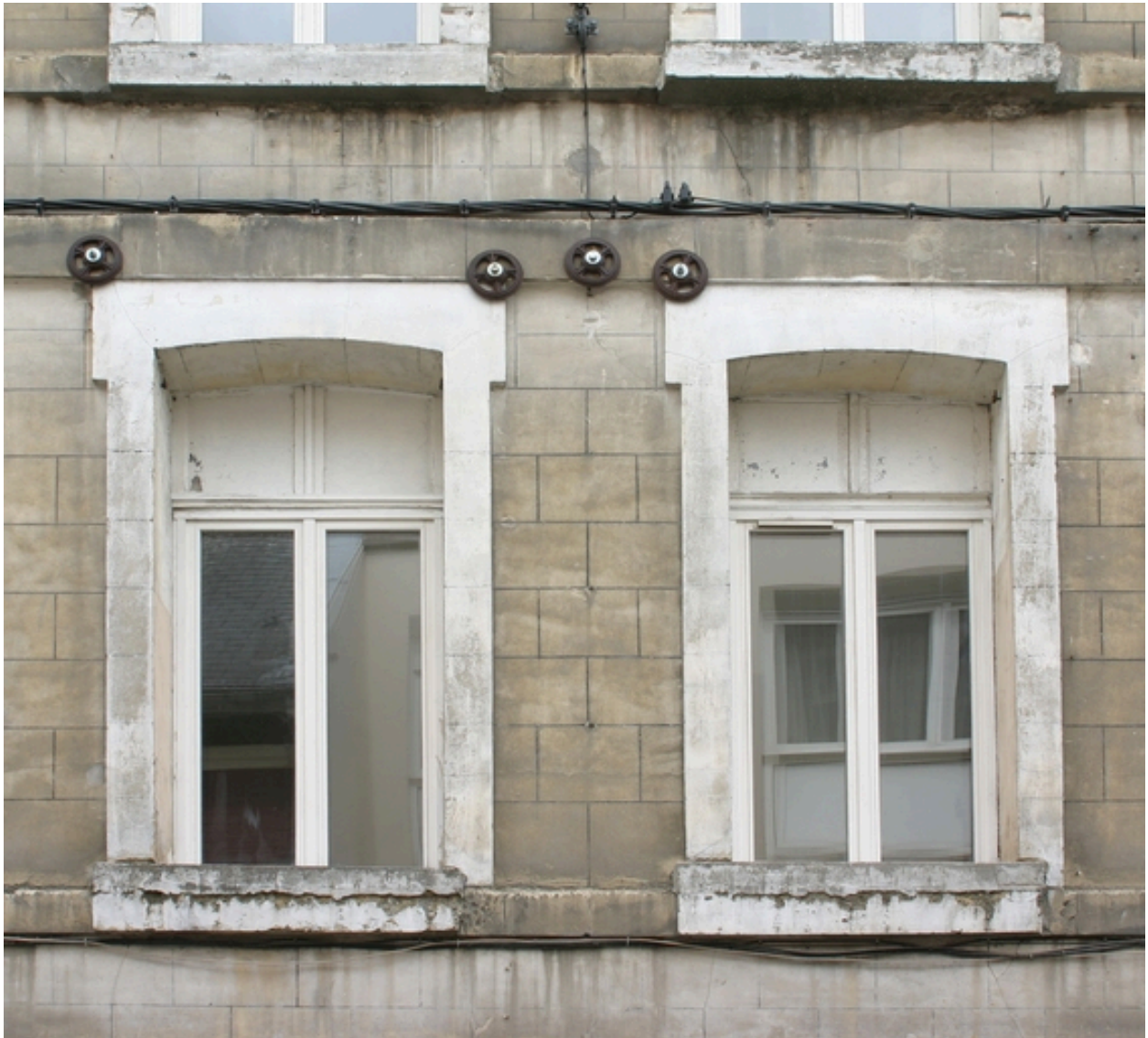
Baies des étages.
