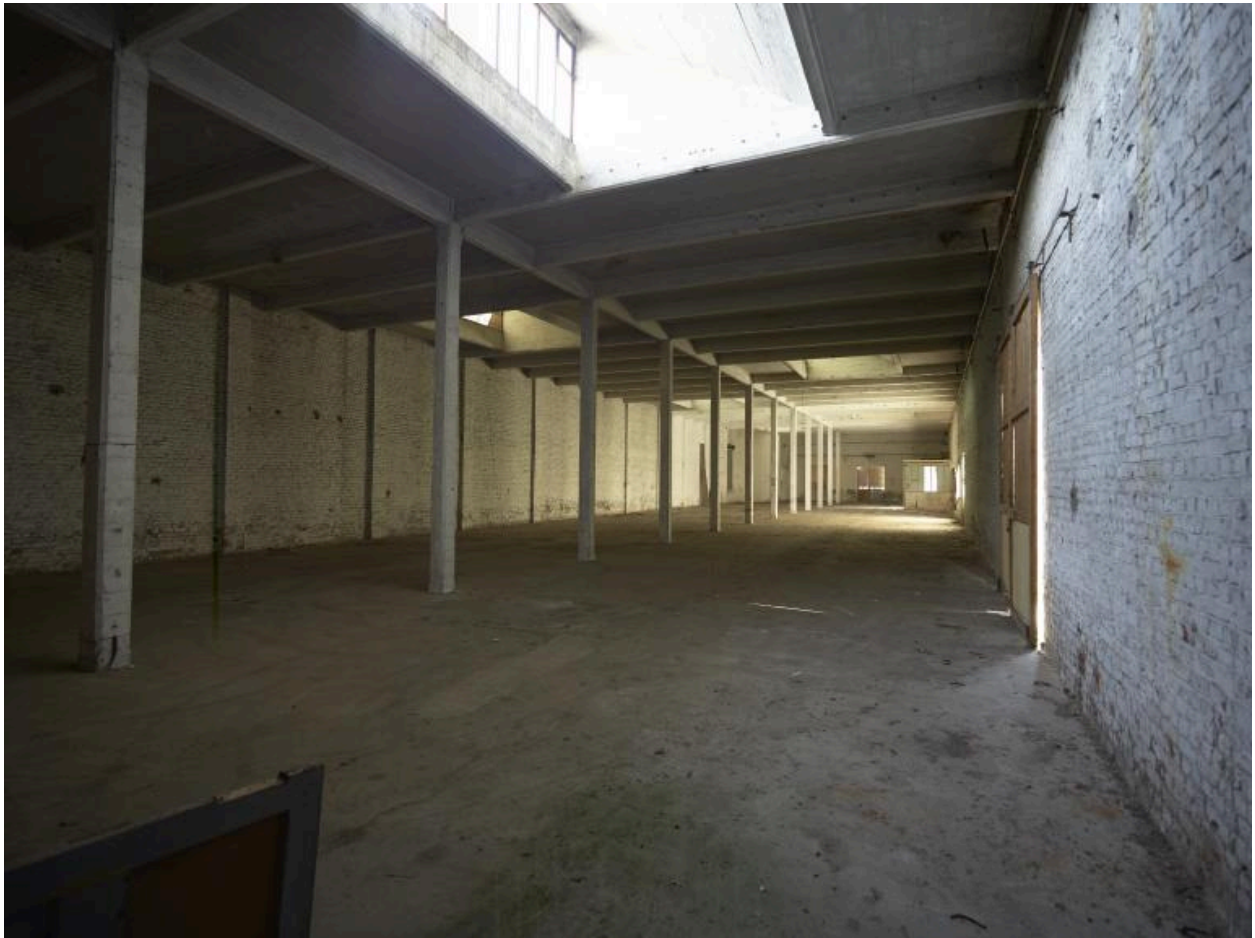
Vue intérieure du magasin aux fils. Vue prise vers l'est.
