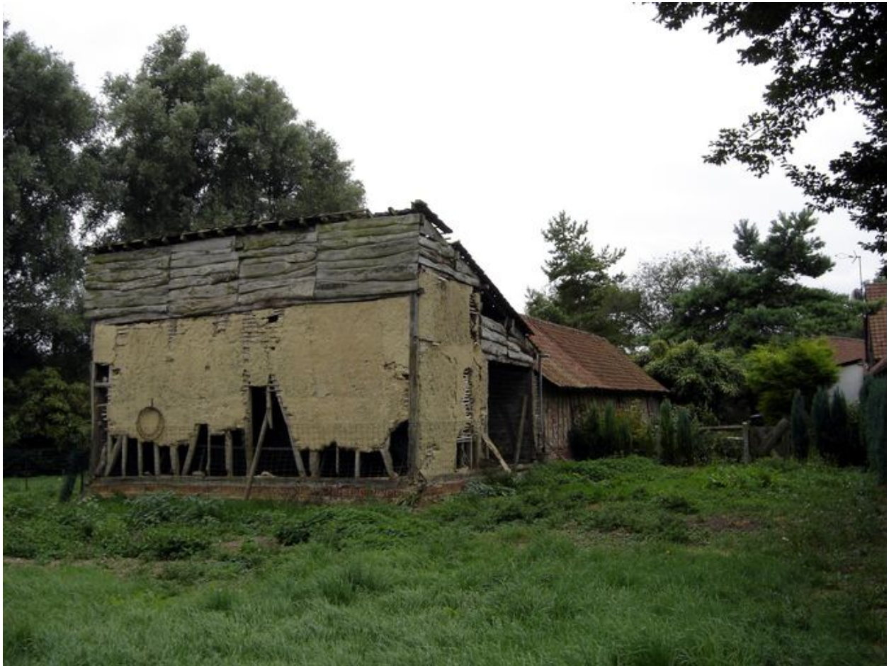
Vue postérieure des dépendances.
