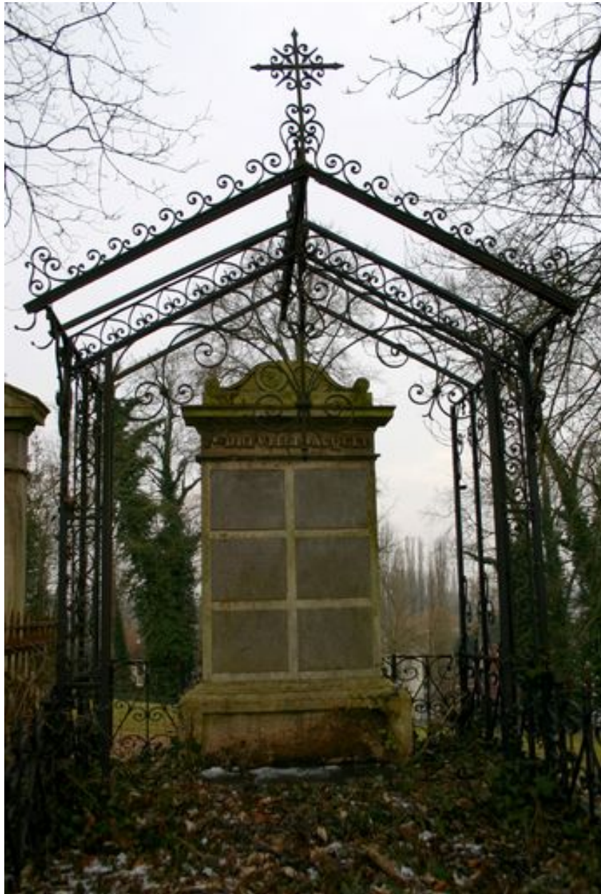
Auvent-verrière à usage de porte-couronne mortuaire.
