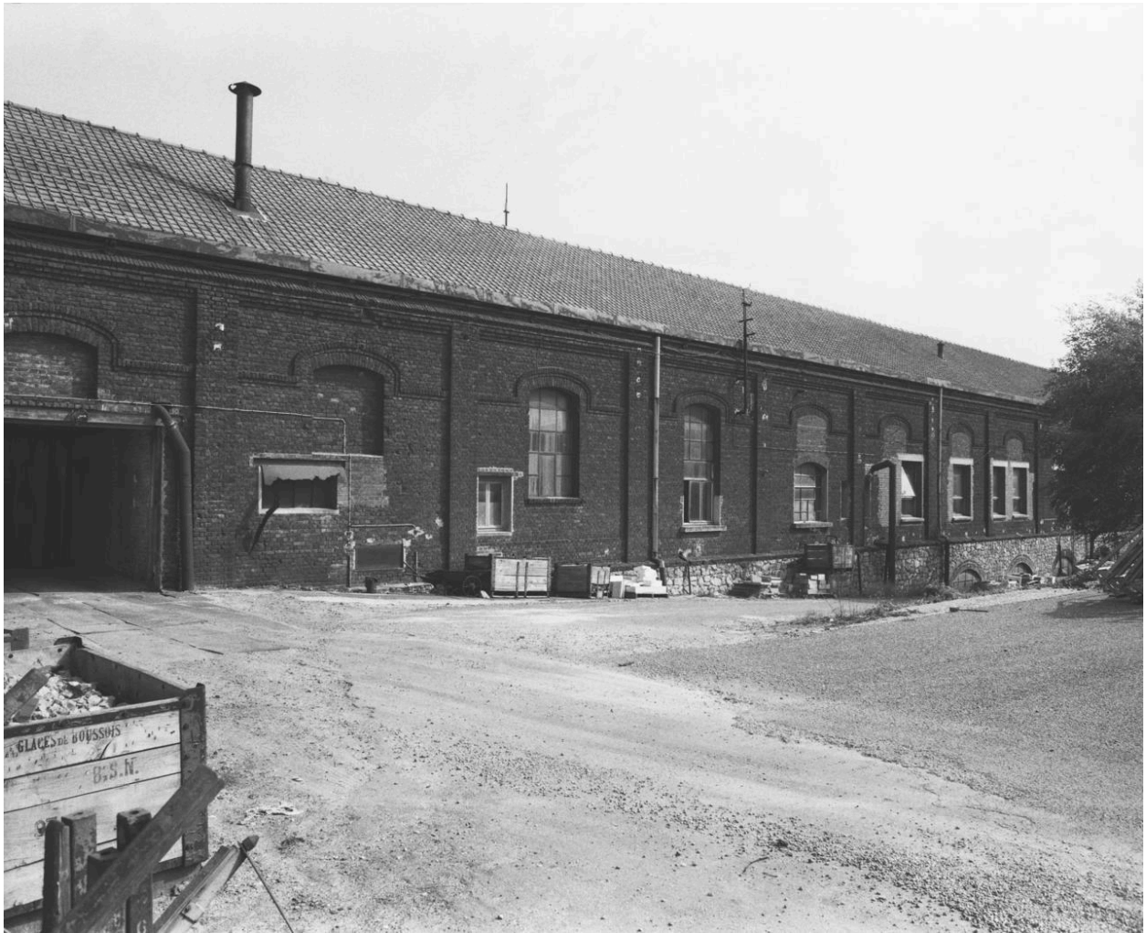
Vue générale de la halle à coulée.
