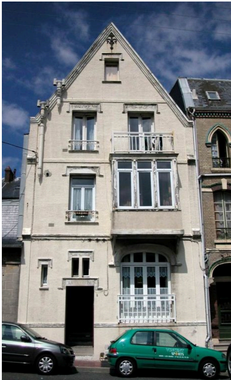
Vue d'ensemble, état en 2003, avant la mise en couleur.
