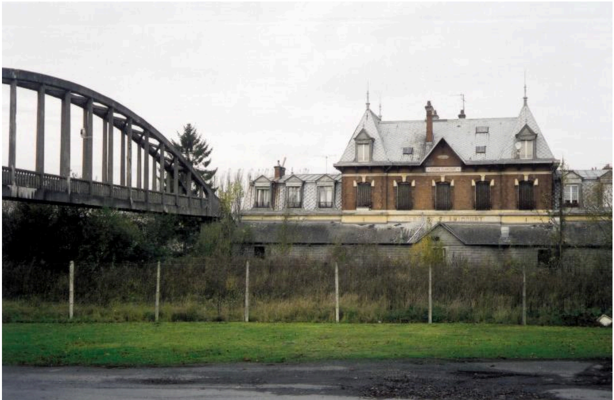
Vue d'ensemble de la gare avec la passerelle.
