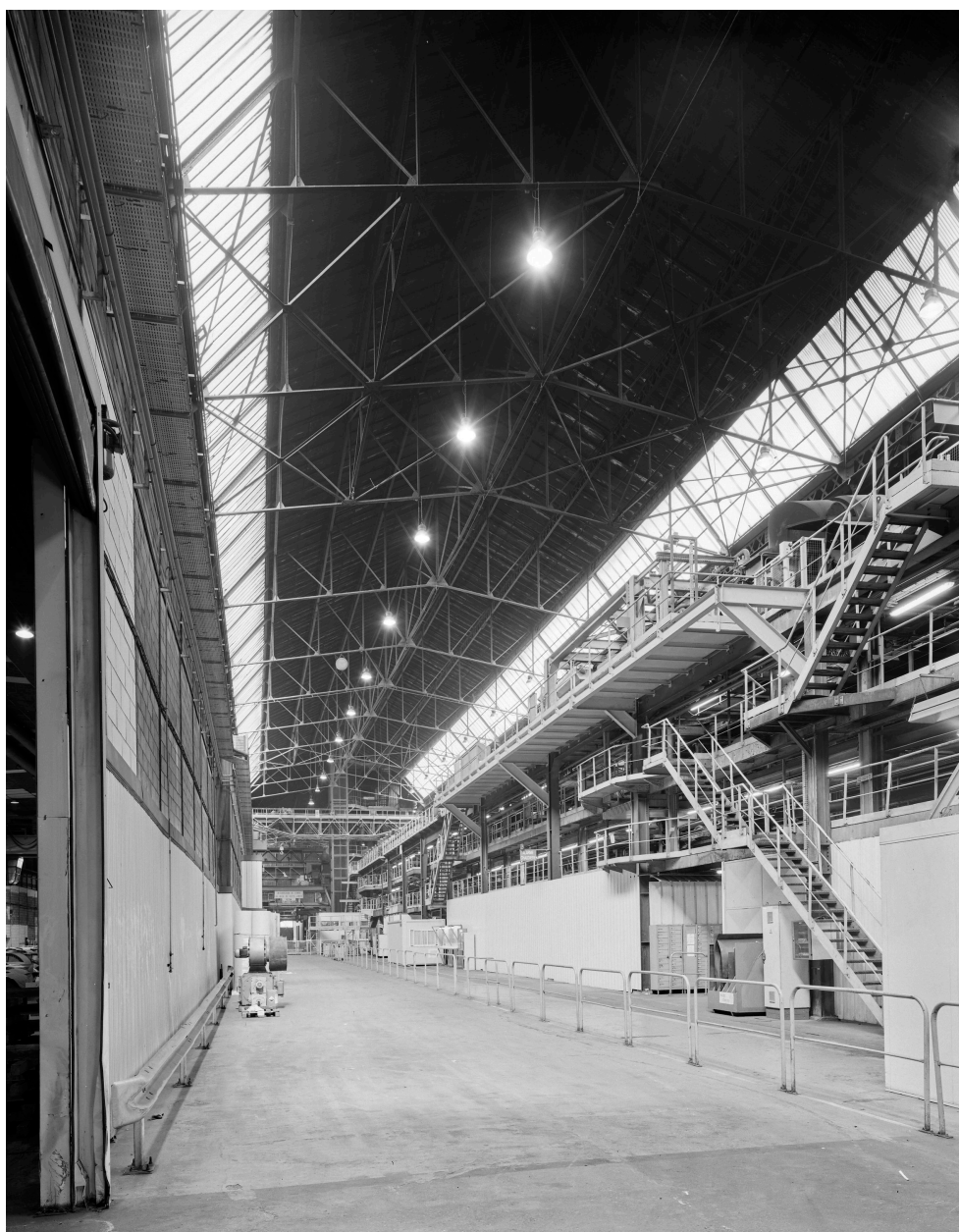
Vue générale de la deuxième ligne de galvanisation des tôles, située dans les halles des anciens laminoirs.
