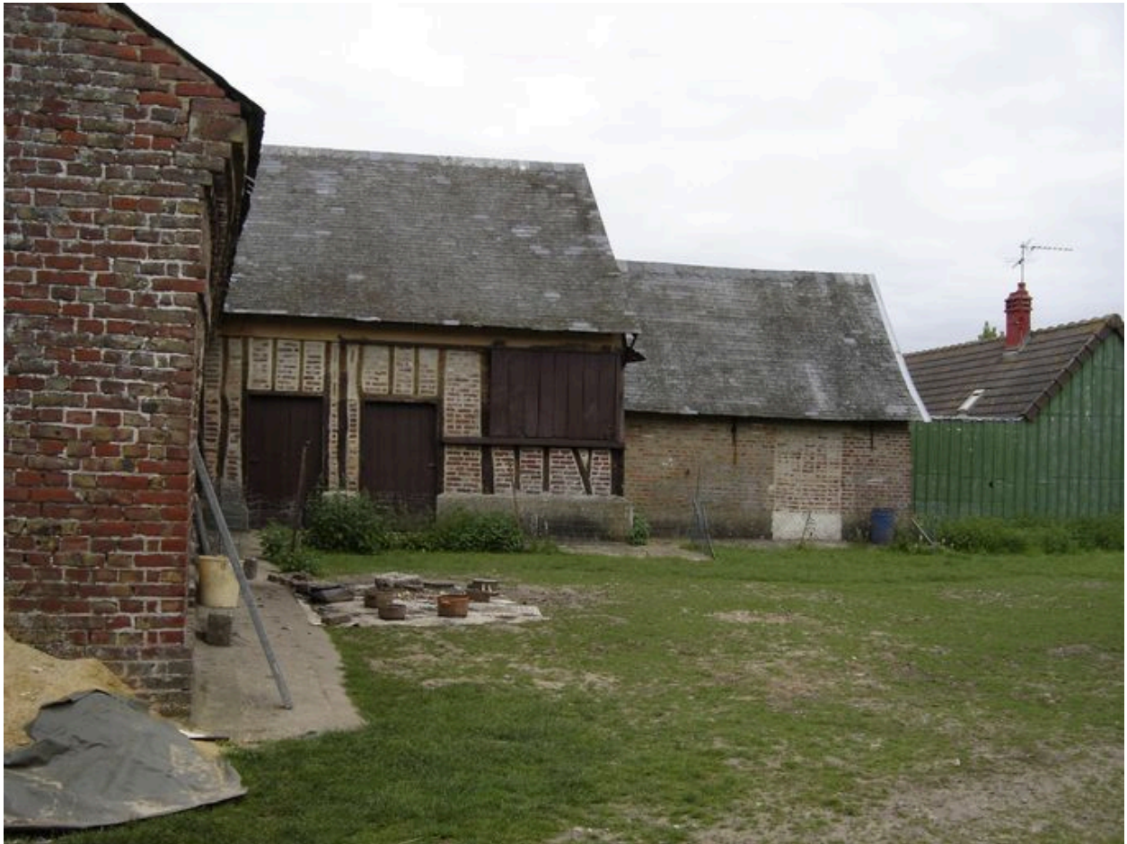
Vue de la disposition intérieure de l'ancienne partie habitable.
