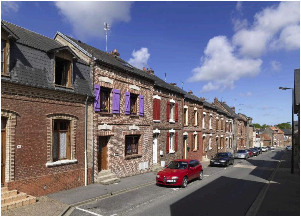
Vue générale depuis le nord.
