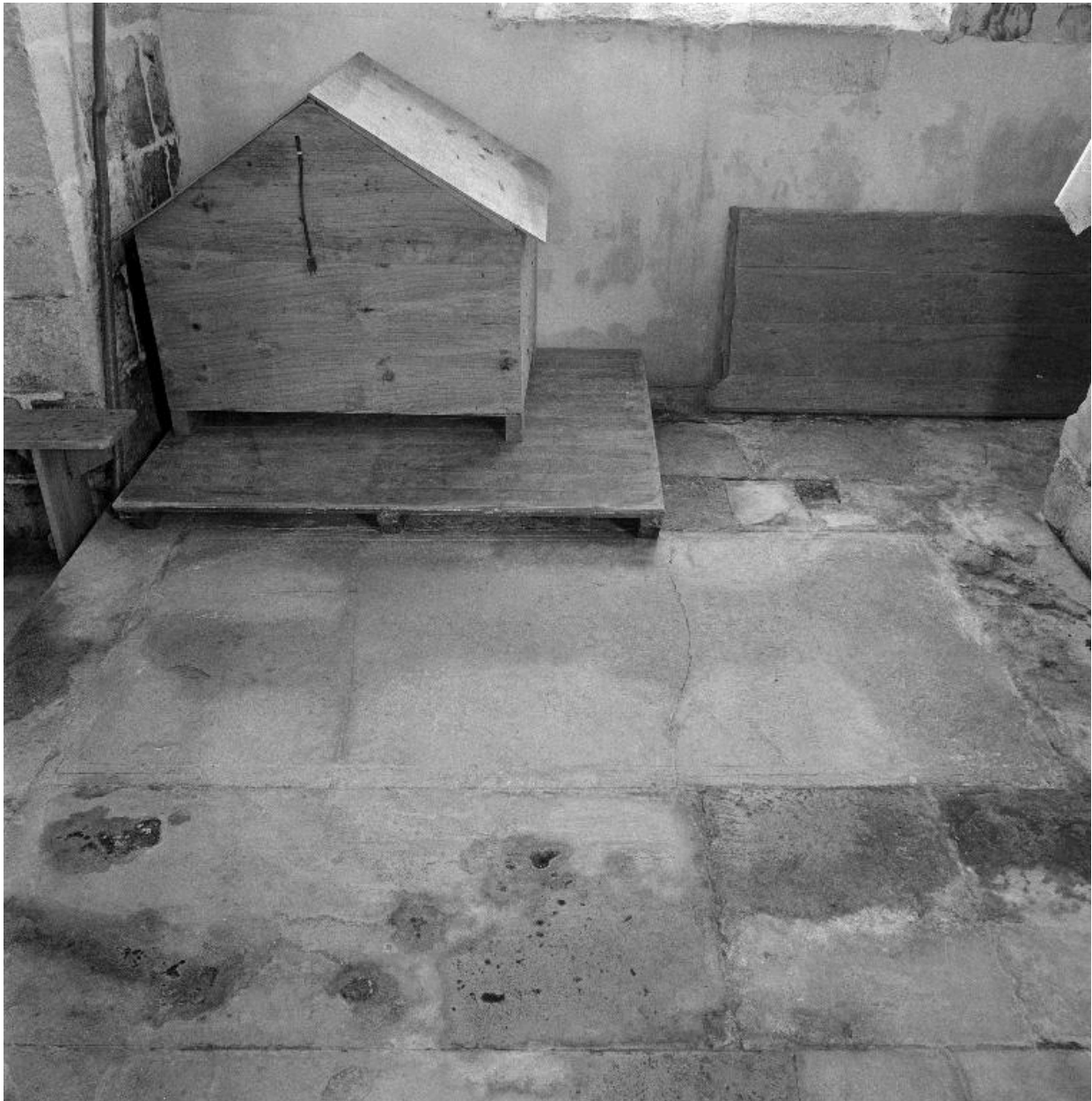
Vue générale de la dalle.
