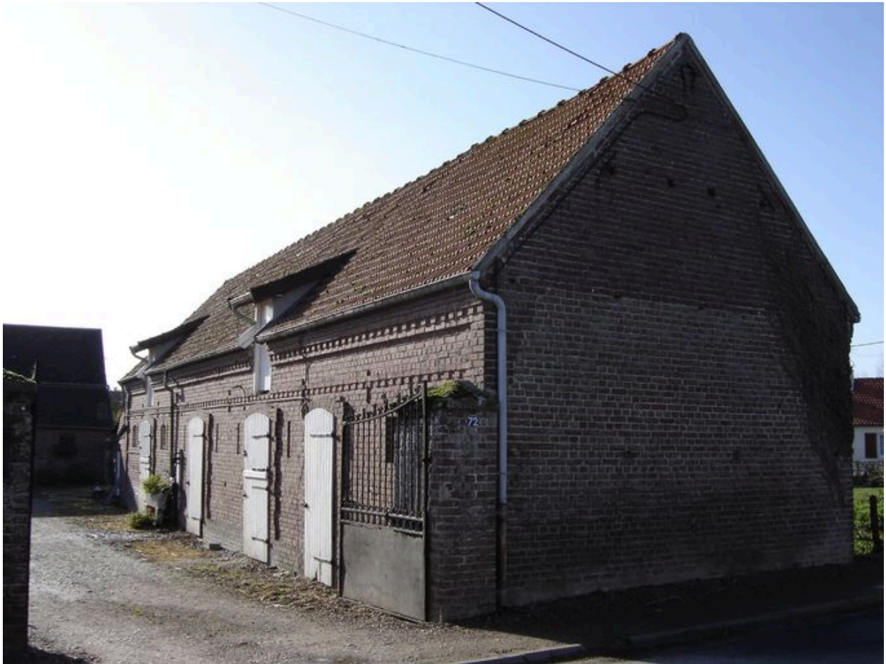
Vue des écuries.
