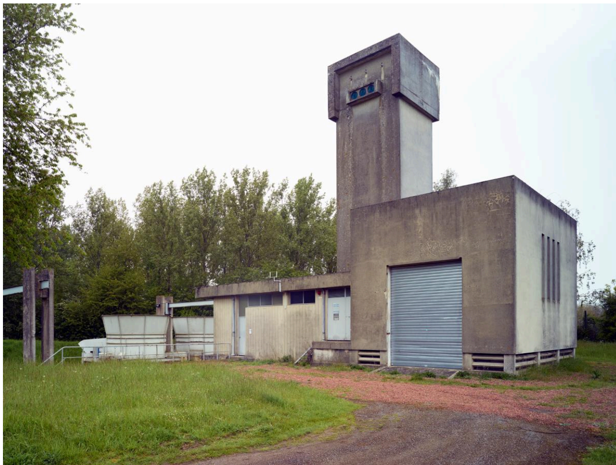
Poste de commande, façade sud. Vue depuis le sud-est.
