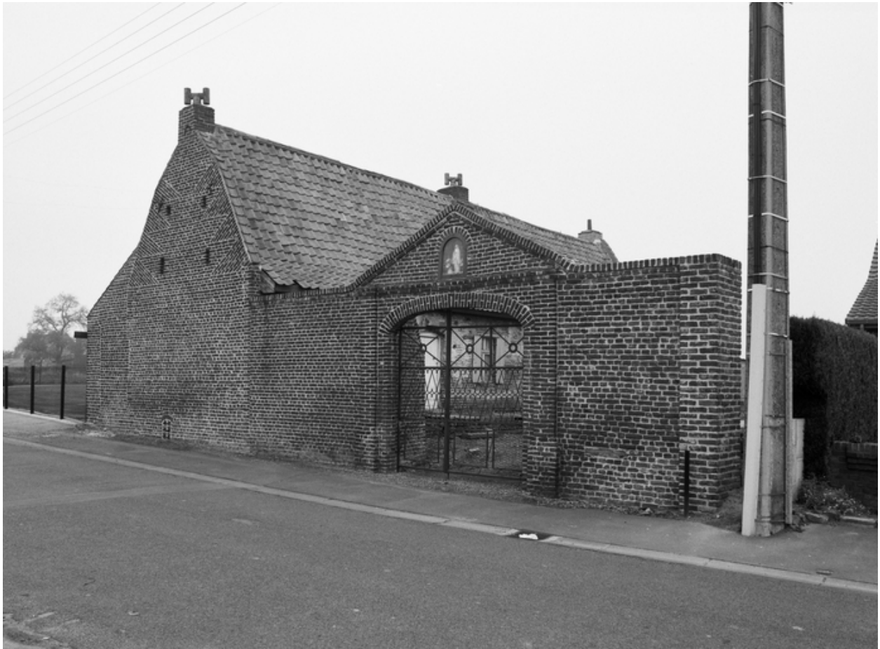
Vue générale depuis la rue de Guivarmez.
