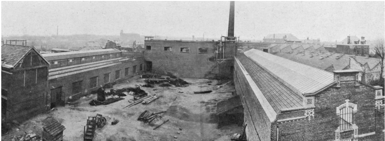
Cour de l'usine après la reconstruction, vers 1921 (Le Monde Illustré).
