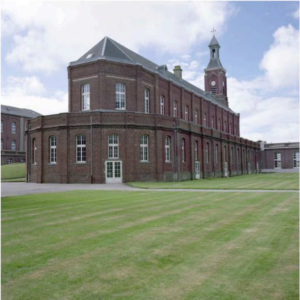
Cour d'honneur, chapelle, élévation latérale nord et chevet, vue d'ensemble,
