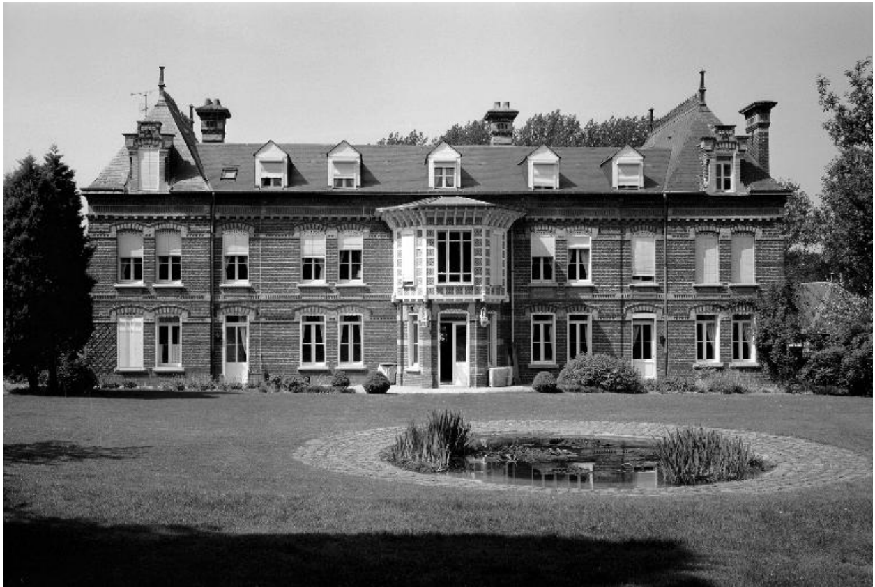
Vue générale de la façade postérieure.
